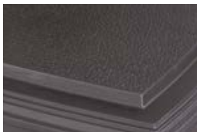
Detalhe textura do teto.
