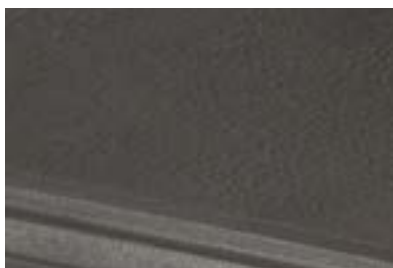
Detalhe textura do teto.
