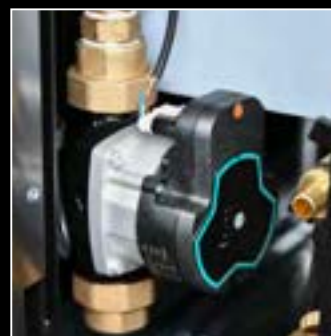
Pompa per circuito di riscaldamento
